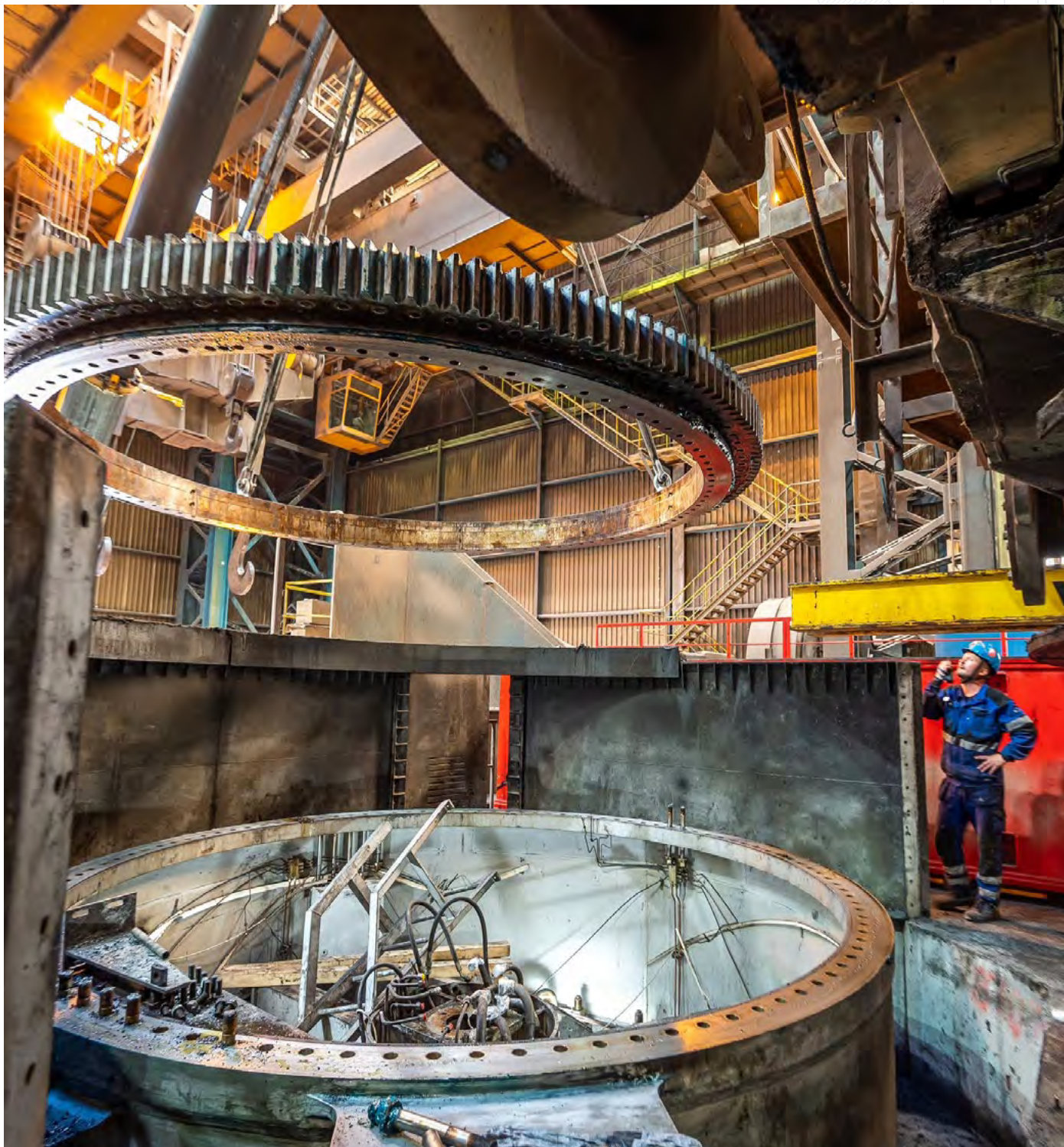
Výměna ložiska otočného licího stojanu včetně opravy mazacího systému a hydrauliky ZPO
