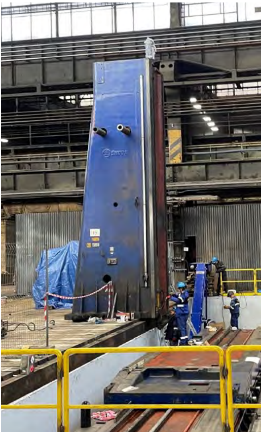
Stěhování a montáž obráběcích strojů
