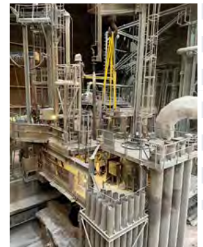
Opravárenské a servisní práce v hutním provozu
